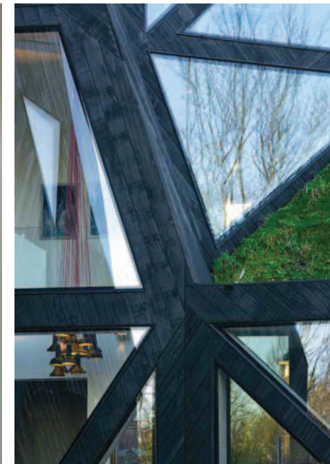
Le bois Accoya®, traité écologiquement par le fabricant britannique Accsys technologies, est utilisé pour la façade de la maison pour sa très bonne résistance aux intempéries.
